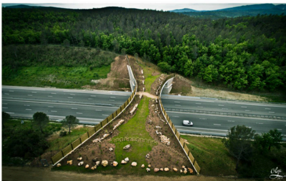
Vue générale de l'écopont de Brignoles avec la ligne intermittente des éco-restanques sur le côté gauche de l'ouvrage. photo : OLGA Création (printemps 2013)
