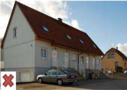
1. Absence de transition
